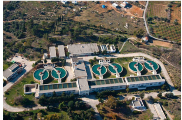
Şekil 22. Berdan İçmesuyu Arıtma Tesisi Genel Görünüm
