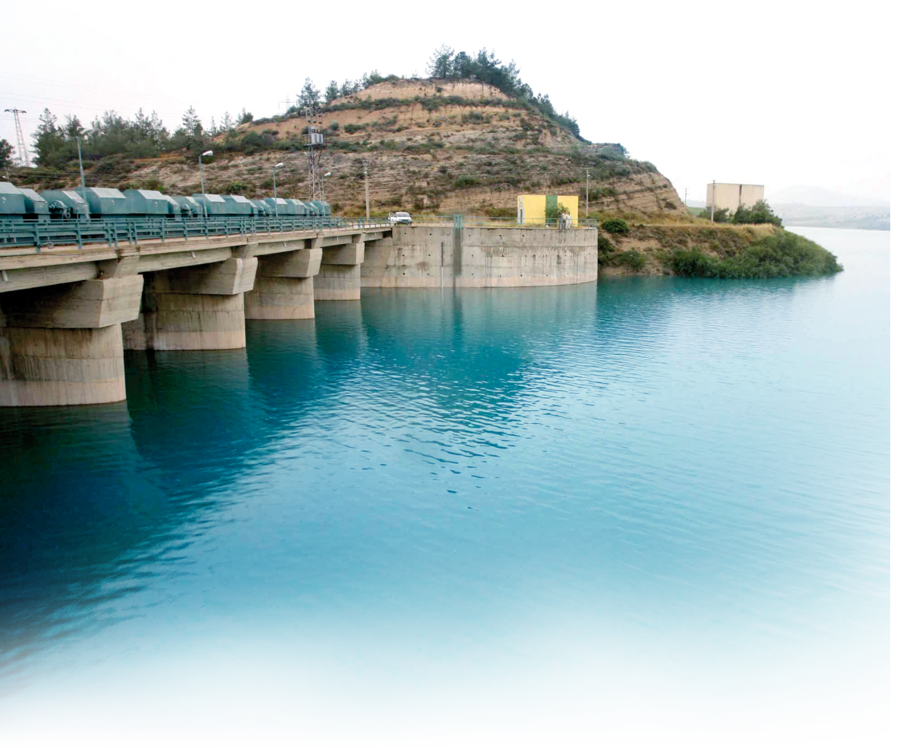
Şekil 23. Berdan Baraj Kapakları
